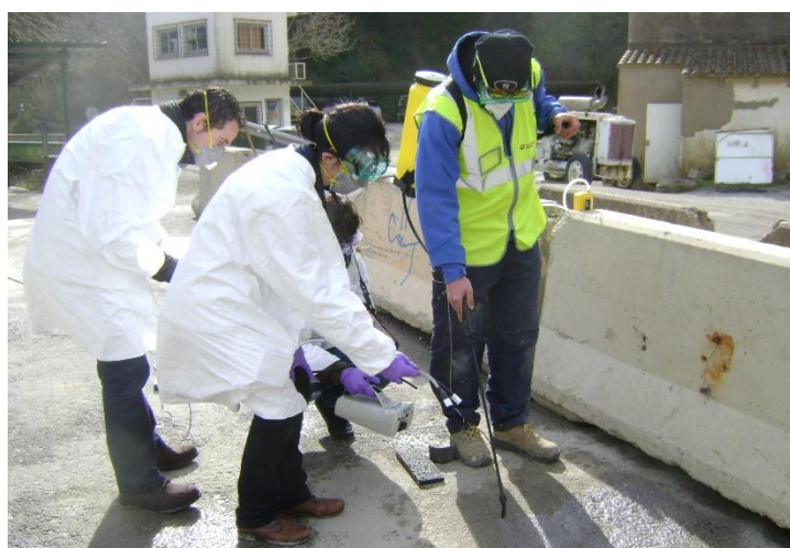
Figura 3. Aplicación de recubrimiento fotocatalítico basado en nanomateriales
